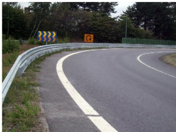
Sama moottoritien ramppi, johon on asennettu uusi kaide, jonka alaosa on liukusuojattu.
